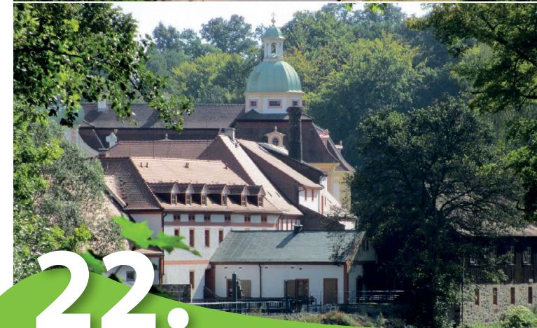
Wasserkraftanlage Bremenwerk, Foto: CTL Celltechnik Lodenau Wasserkraftanlage Kloster Marienthal Ostritz, Foto: Torsten Fechner
